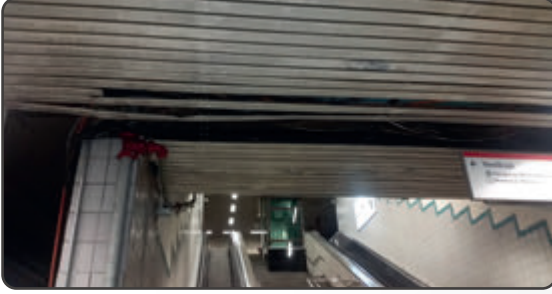
Aksaray İstasyonu: Asma Tavan Onarım Öncesi
