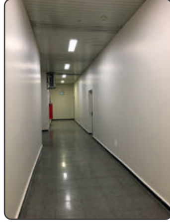
Havalimanı İstasyonu Boyama Öncesi
