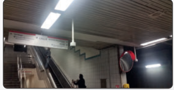
Aksaray İstasyonu: Asma Tavan Onarım Sonrası
