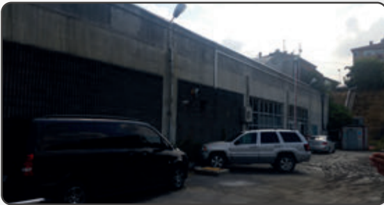
Bakırköy İstasyonu Boyama Öncesi
